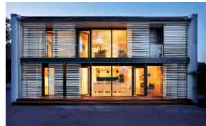
Die Südseite mit ihren beweglichen Sonnenschutzlamellen öffnet sich zum Garten – die puristische Funktionalität des Hauses steht im Kontrast zum „warmen“ Wohngefühl mit der Holz-Einrichtung.
